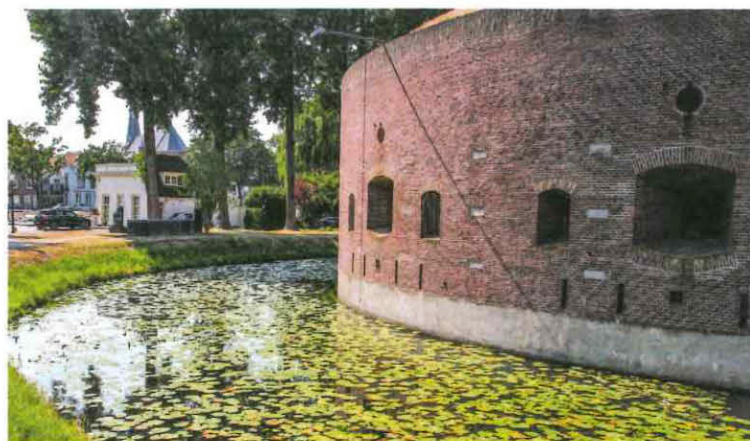
Fort aan de Ossenmarkt in Weesp.
